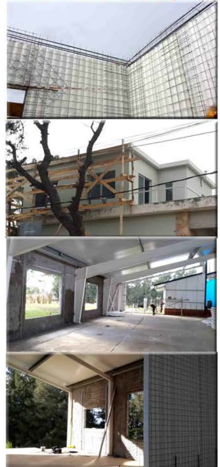
Encuentro Isodec®-muro de Concrepsuma
