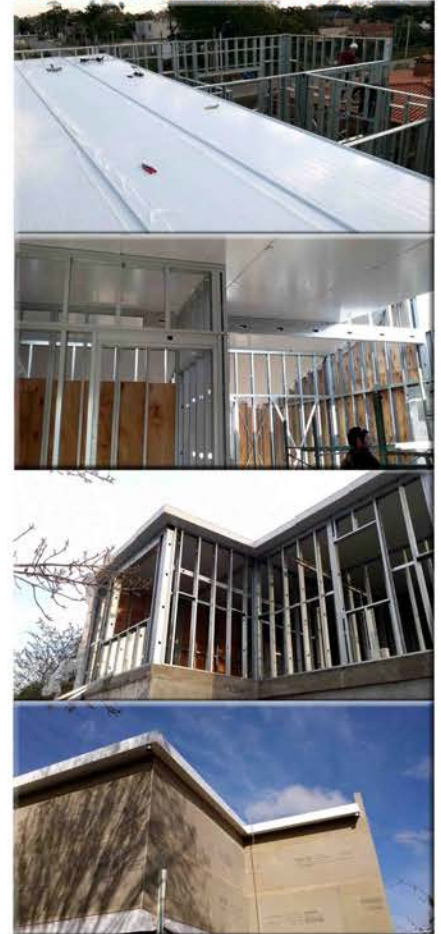
Encuentro Isodec®-muro de Concrepsuma
